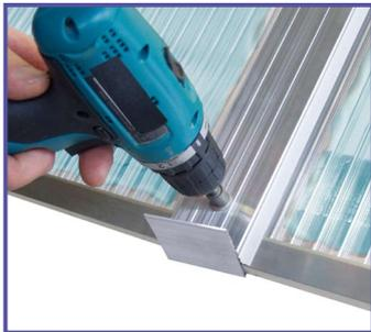
Nacheinander immer zwei Platten auflegen, ausrichten und fixieren. Profiloberseite Rand und Mitte auflegen und mit Scobalit Edelstahlschrauben Metall (6,3 x 32 mm) oder Bohrschrauben (5,5 x 34 mm) mit dem Unterteilen verschrauben. Fortfahren bis zur letzten Platte. Diese dann einmessen, ggf. zuschneiden und mit Randprofil montieren.
