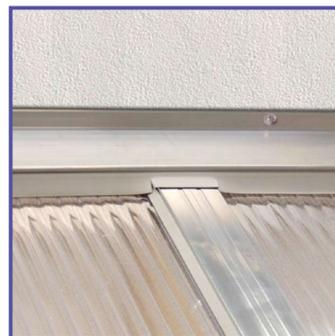
Schneiden Sie den Dichtgummi des Abschlusswinkels an den Profilen ein, damit er auf den Platten besser anliegt.
