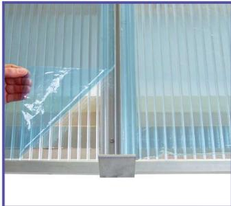
Legen Sie die Platte auf und richten Sie winkeltgerecht aus. Plattenabstand 28 mm. Die gekennzeichnete Schutzfolie nach oben - UV-Schutz!
