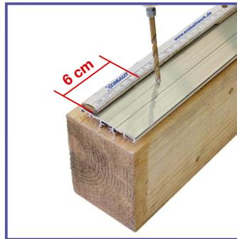
Profiloberteile im Abstand von 40 cm mittig vorbohren ( $\varnothing$  7 mm). Der Abstand der ersten Bohrung zur vorderen Kante beträgt 6 cm.
