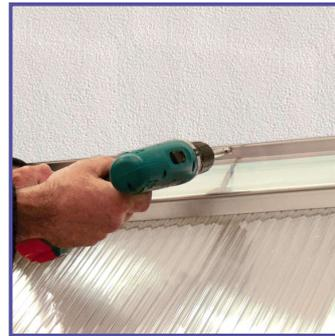
Verschrauben Sie das Profil mit geeigneten Schrauben.
